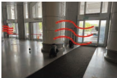
改善前：大廳自動門位於風口，室外熱空氣直接灌入大廳，熱空氣影響二樓就醫環境
